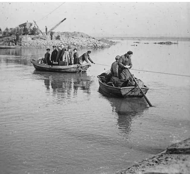
Burghsluis 1953. Dijkdoorbraak omdat het talud het begaf.
