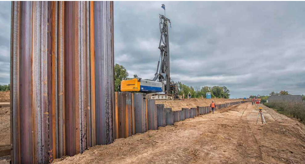
Damwand tegen piping (Opheusden).
