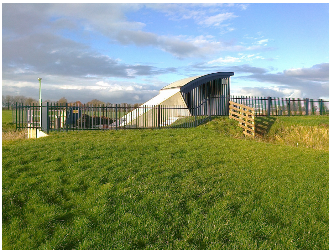
Het nieuwe gemaal van de Rijsterpolder.
