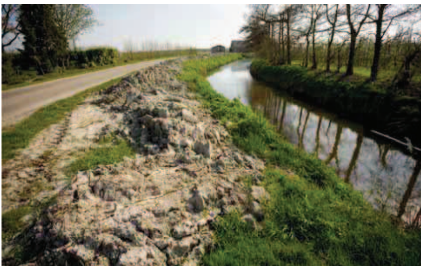
Baggerspecie op de kant
